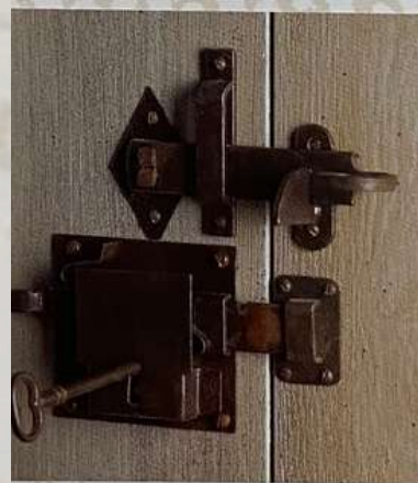
Porta Mod. 803: particolare interno serratura di chiusura tipo sarda con saltarello in ferro battuto invecchiato.
